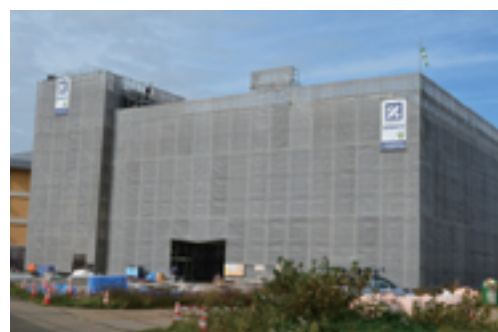
10月末の建設現場
