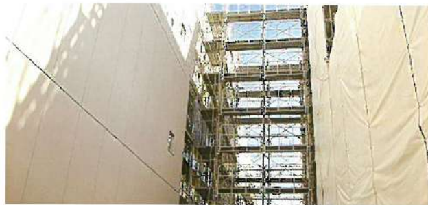
新棟への渡り廊下の工事
