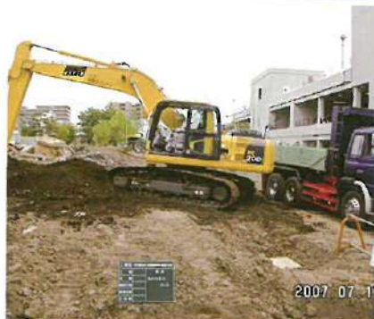
増築棟の基礎工事
